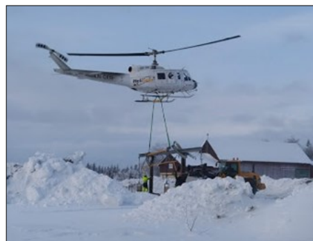
Rationell transport av stolpar med helikopter vid breddning av kraftledningsgatan väst om byn
