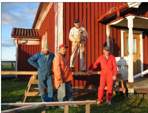
Ingemar, Lage, "Sprutmålarmästaren" Nils och Harry tar en välbehövlig paus, efter väl förrättat varv vid målningen av bygdegården sommaren 2005
